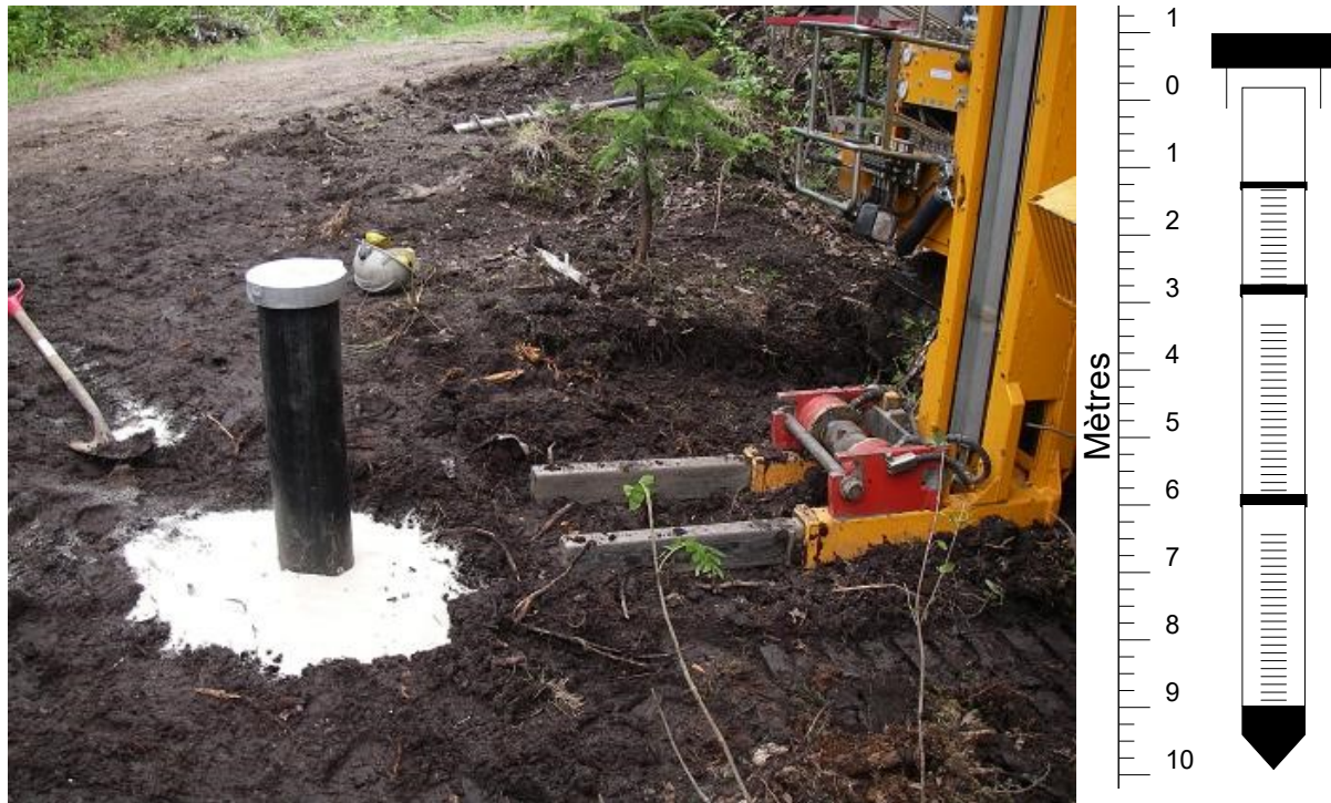
Figure 2. Installation de puits crépiné sur toute l'épaisseur de l'aquifère
